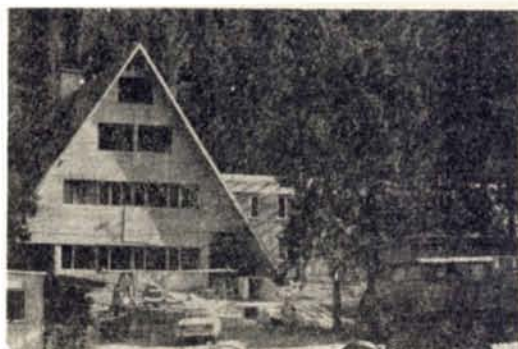
Budowa motelu przy Zwierówce — stan z września 1979 r.
