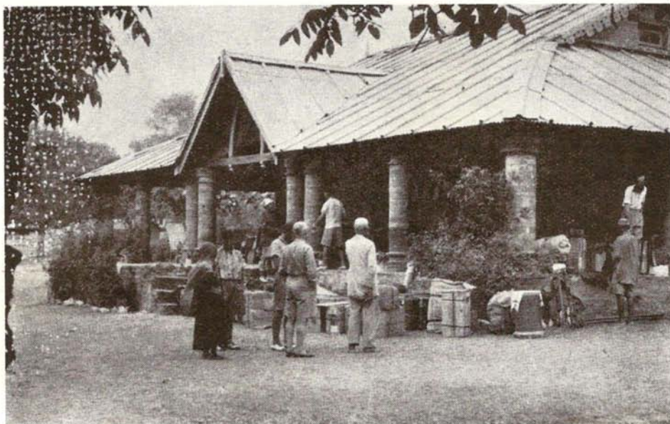
Dak bungalow w Almorze
